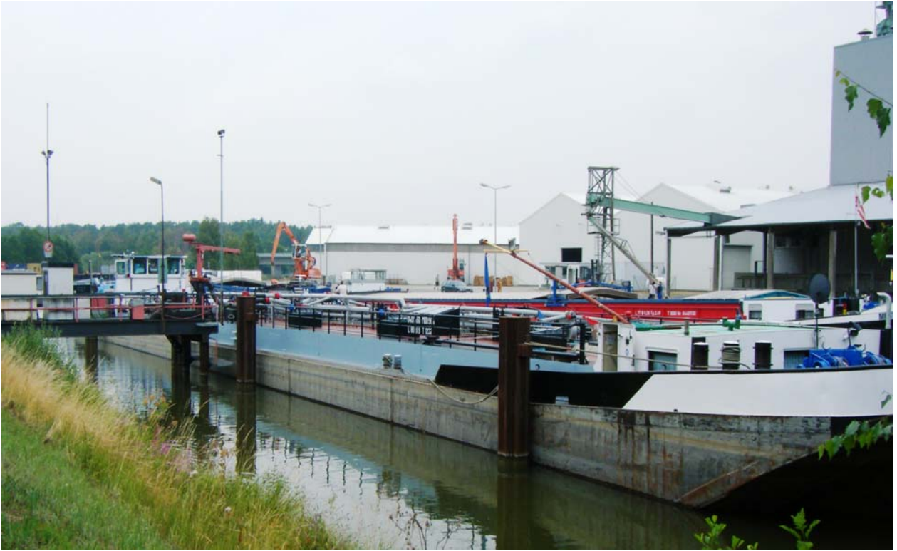
Bunkerstation in Höhe des Grundstücks Fa. Hoyer
