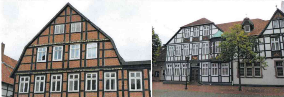
Fotos: Gänsemarkt 2 und 3 (links) und Einzeldenkmal Lange Straße 35 (rechts). Erhaltenswerte und stadtbildprägende, durch Fachwerkelemente und hochrechteckige Fenster gegliederte Fassaden. Die Abstände werden durch traditionelle konstruktive Elemente des Fachwerkbaus vorgegeben.
