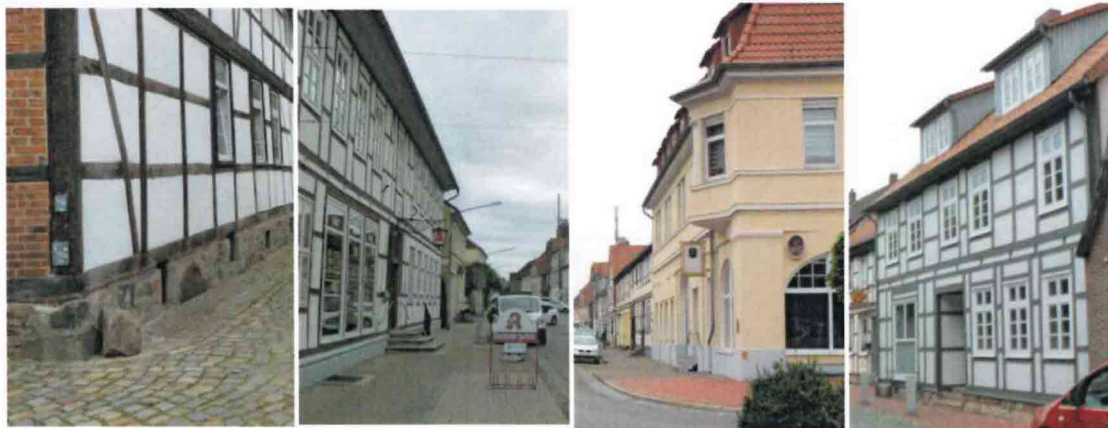
Foto 1: Beispiel für gut gestalteten Natursteinsockel an einem Fachwerkgebäude, verputzte Gefache hell gestrichen, mit Backstein ausgefüllte Gefache freigelegt.
