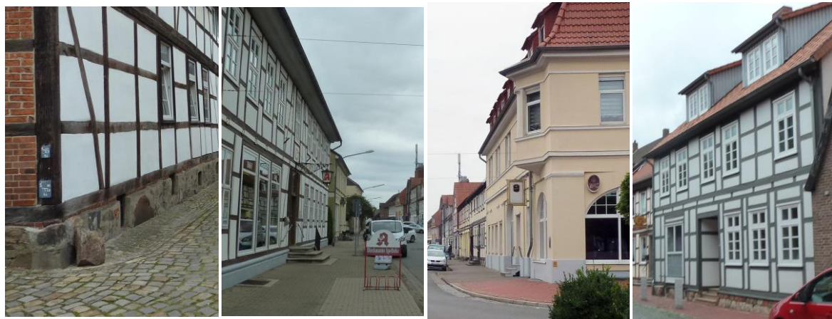
Foto 1: Beispiel für gut gestalteten Natursteinsockel an einem Fachwerkgebäude, verputzte Gefache hell gestrichen, mit Backstein ausgefüllte Gefache freigelegt.
