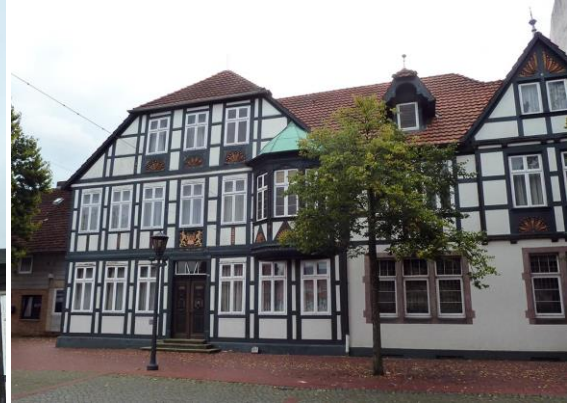
Fotos: Gänsemarkt 2 und 3 (links) und Einzeldenkmal Lange Straße 35 (rechts). Erhaltenswerte und stadtbildprägende, durch Fachwerkelemente und hochrechteckige Fenster gegliederte Fassaden. Die Abstände werden durch traditionelle konstruktive Elemente des Fachwerkbau vorgegeben.
