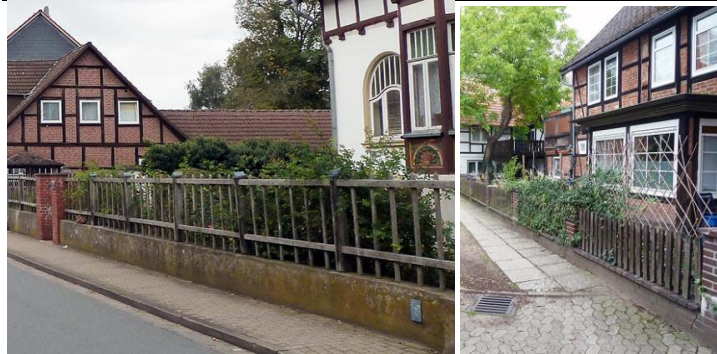
Fotos: vorbildhafte Gestaltung von Einfriedungen privater Grundstücke; Ausführung in geringer Höhe und in ortstypischen Materialien.
