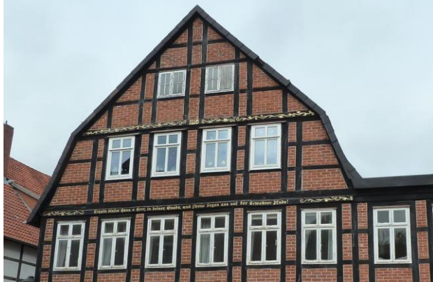
Fotos: Gänsemarkt 2 und 3 (links) und Einzeldenkmal Lange Straße 35 (rechts). Erhaltenswerte und stadtbildprägende, durch Fachwerkelemente und hochrechteckige Fenster gegliederte Fassaden. Die Abstände werden durch traditionelle konstruktive Elemente des Fachwerkbau vorgegeben.
