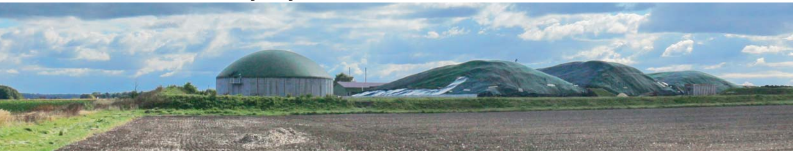
Abb. 3.2/4 Biogasanlage bei Plastau
