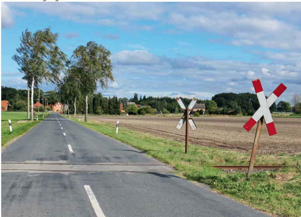
Abb. 1.2/4 Stillgelegte OHE-Trasse bei Plastau
