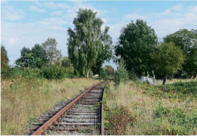
Abb. 3.3/7 Gleisanlagen der stillgelegten OHE-Trasse bei Wittingen
